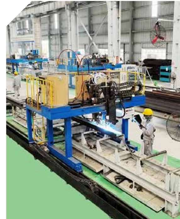
1 CHẾ TẠO & HÀN ĐÀ NGANG FABRICATION & WELDING CROSS BEAMS
