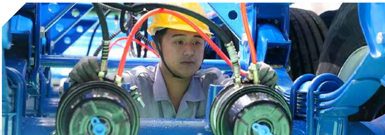
6 LẮP RÁP HOÀN THIỆN HỆ THỐNG HƠI AIR SYSTEM CONNECTION AND FINALIZING
